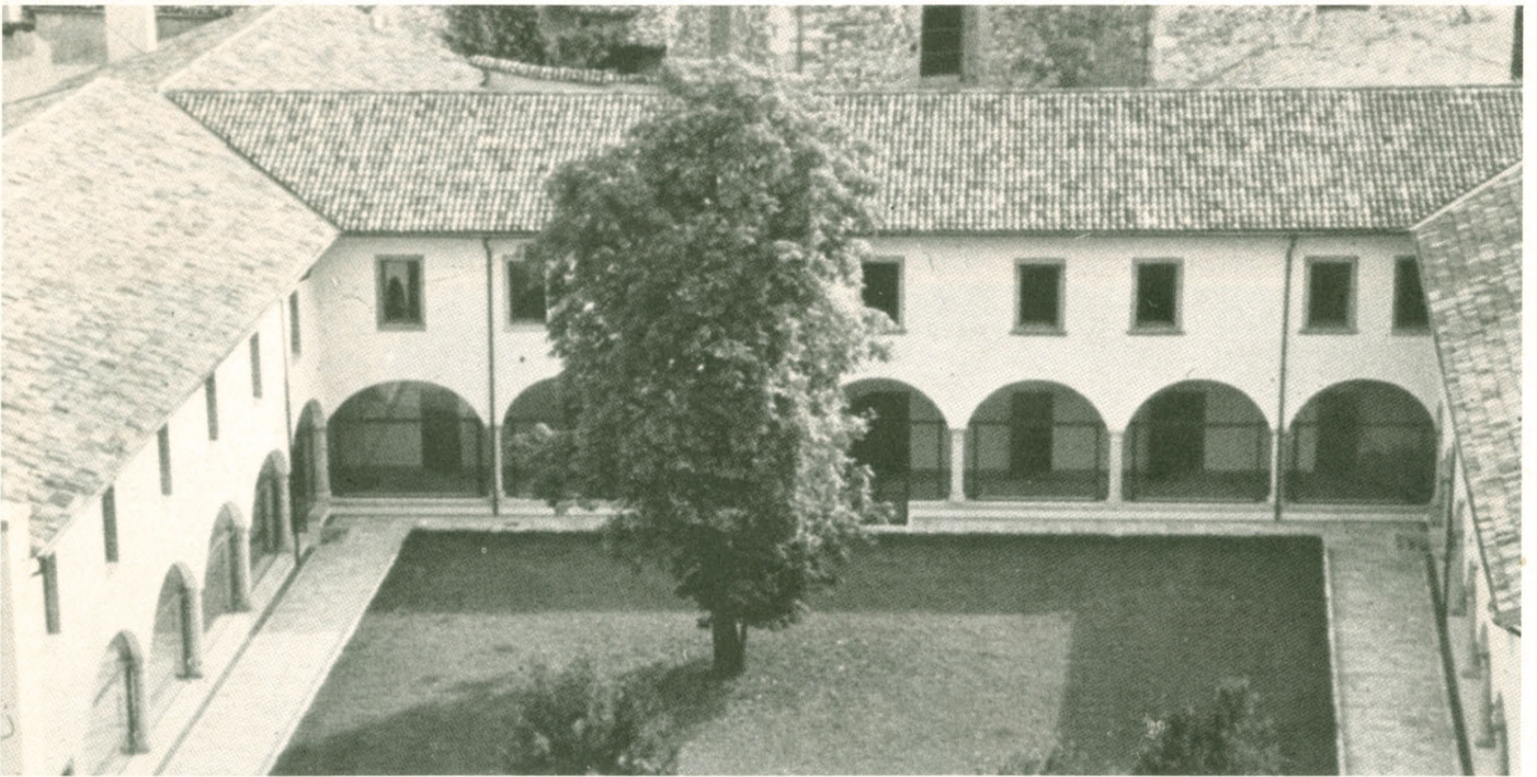
Udine, ex convento degli Agostiniani ora sede della Biblioteca Unificata, del Centro di calcolo e della Facoltà di Lettere: il chiostro fotografato prima e dopo l'intervento di restauro.
